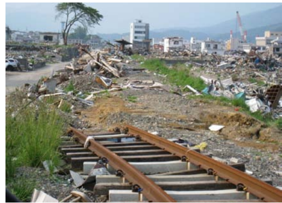
図-2 切断された大船渡線（湾奥に向かって撮影，撮影は大成由音氏，2011年6月29日）
